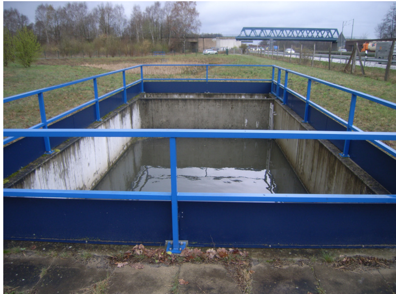
RiStWag Abscheider mit nachgeschaltetem RRB
