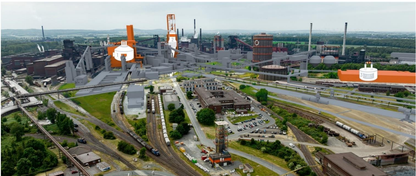
1 Elektrolichtbogenofen; 2 Direktreduktionsanlage; 3 Elektrolyseanlage (100 MW)
