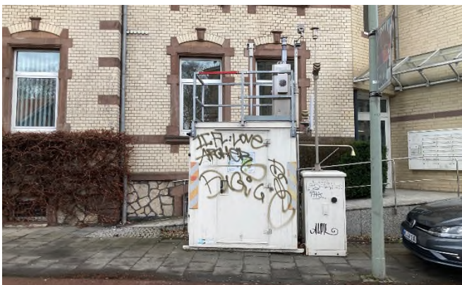
Abb. 5.21: Blickrichtung SSW (Süden)
