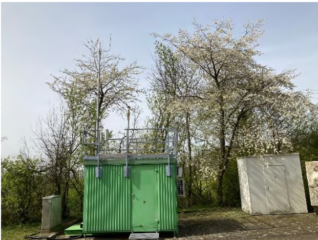
Abb. 5.166: DENI011 Braunschweig (BGSW) (Bildaufnahme April 2022)
