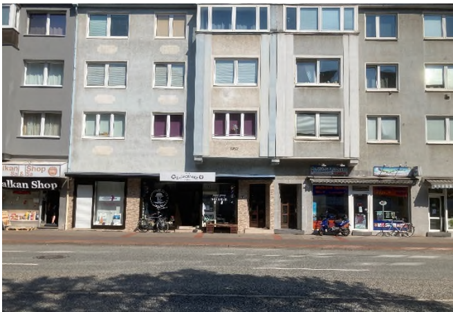
Abb. 5.65: Blickrichtung NNW (Norden)
