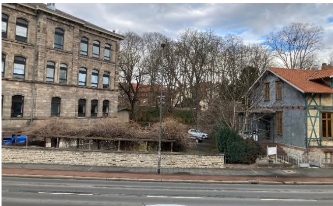
Abb. 5.19: Blickrichtung NNO (Norden)
