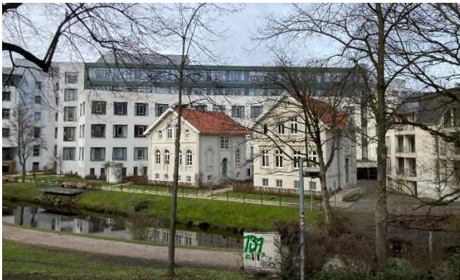
Abb. 5.88: Blickrichtung NNW (Norden)
