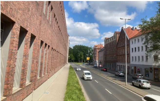
Abb. 5.35: Blickrichtung NNW (Norden)
