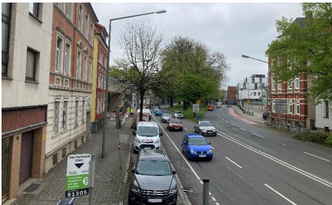
Abb. 5.96: Blickrichtung NNW (Norden)
