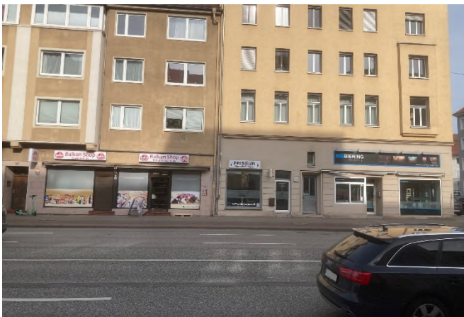
Abb. 5.73: Blickrichtung NNW (Norden)
