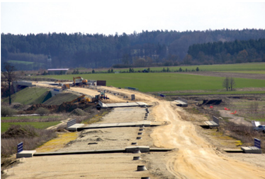
Abb. 2: Der Bau von Straßen in der Agrarlandschaft ist zumeist mit einem Verlust von Vorkommen der Feldlerche (s. S. 47) verbunden. Die Anlage von Ackerbrachen mit Selbstbegrünung (A1, s. S. 63) bietet der Feldlerche neue Brut- und Nahrungshabitate, auf denen sie eine höhere Siedlungsdichte erreichen kann, als auf „normal“ bewirtschafteten Feldern. (Foto: W. Willner/blickwinkel.de)
