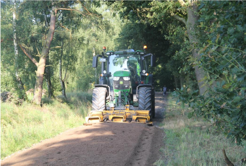
Wegeunterhaltung im forstlichen Wegebau (NLF)
